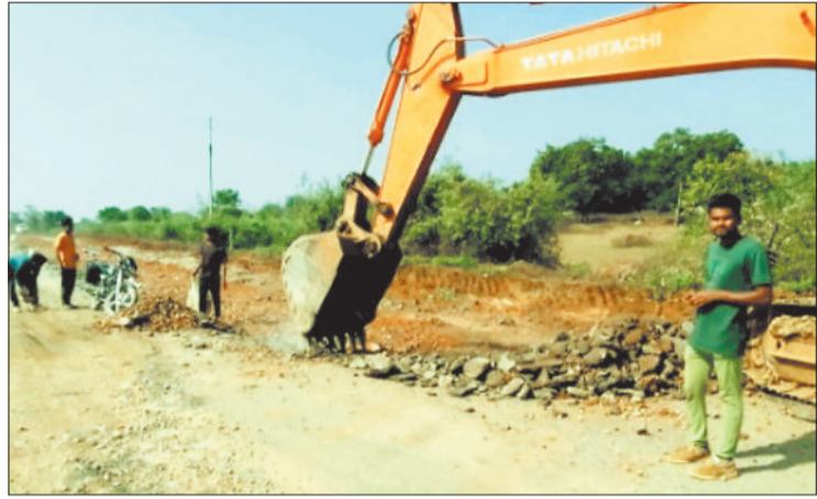
सड़क का निर्माण कार्य तेजी से जारी।
